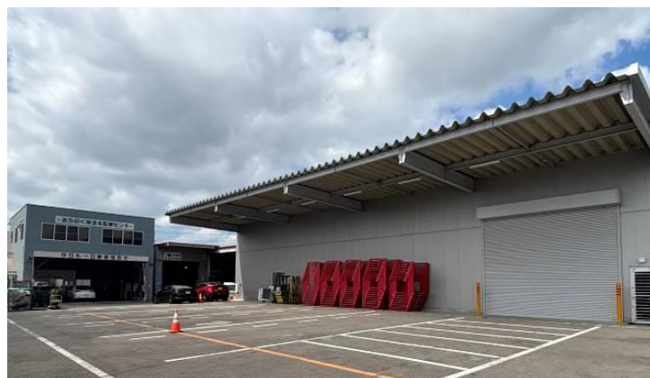
▲福島県福島市飯坂町にある本社、倉庫 （出所：みちのく陸運提供）
