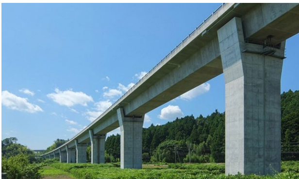
常磐道木戸川橋下部工工事
