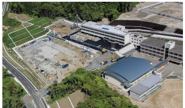
災害復興豊間中学新設工事
