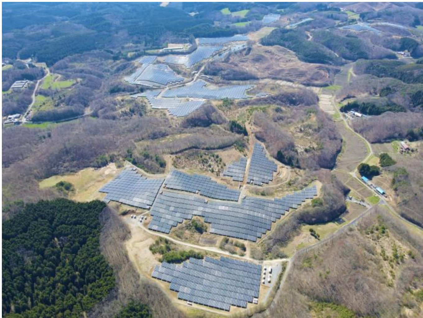
鮫川青生野太陽光発電所全景
