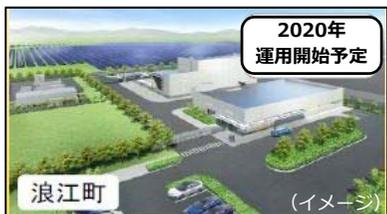
浪江町において、再生可能エネルギーを用いた大規模水素製造、次世代の水素輸送・貯蔵技術の実証に取り組む。
