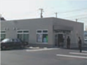
ローンプラザ須賀川支店
