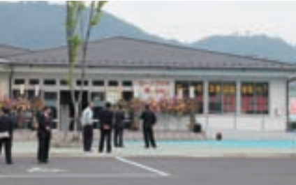
当行初のローン特化型店舗であるローンプラザ福島支店
