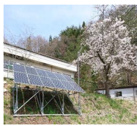
太陽光発電システム
