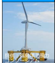
浮体式洋設備上風力 発電「ふくしま未来」
