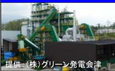
木質バイオマス発電所
