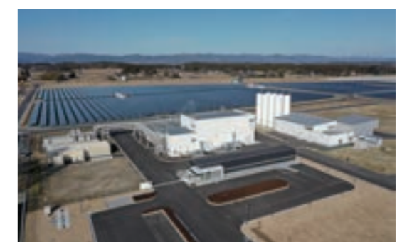
「福島水素エネルギー研究フィールド」
